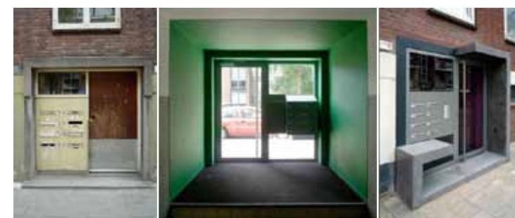
4. Rehabilitación del hueco de la escalera por Woonbron / Rehabilitation of the stair well by Woonbron
