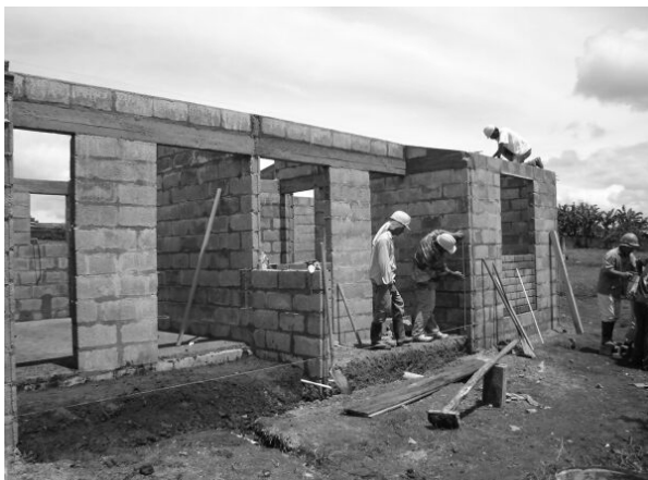
Fig. 7. Construcción de vivienda de Interés Social, 2008. Fuente: Circulación libre de internet
